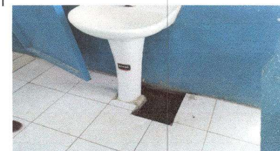
FOTO 12: Reparación de tapaderas de cajas
