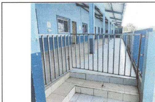
FOTO 9: Fabricación e instalación de portón de metal de ingreso
