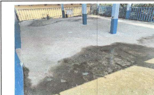
FOTO 8: Sustitución de piso cerámico
