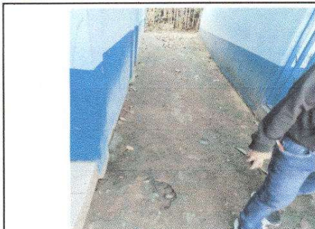
FOTO 7: Reparación de piso de torta de concreto
