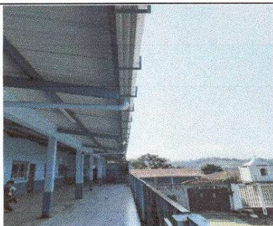
FOTO 3: Sustrucción de canal de metal
