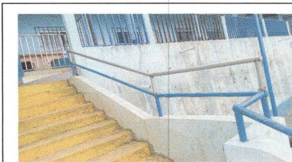
FOTO 10: Fabricación e instalación de baranda de gradas
