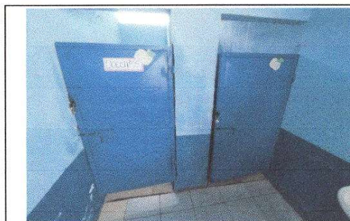
FOTO 11: Mantenimiento a estructura (lijado, cambio de tubo, cepillado, sujeciones aplicación de pinturas) a puertas servicios sanitarios
